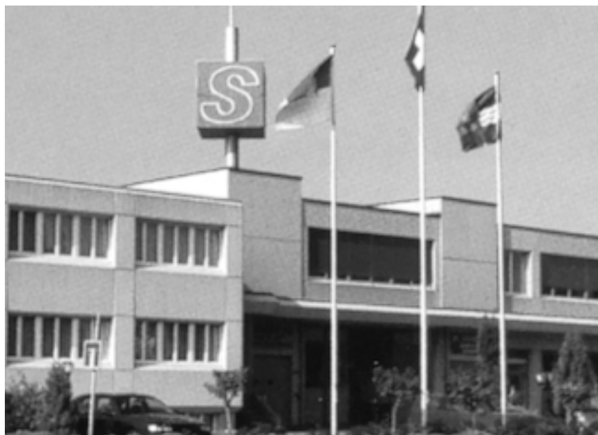
Das neue Büro- und Fabrikationsgebäude der Storatex Systeme AG.
