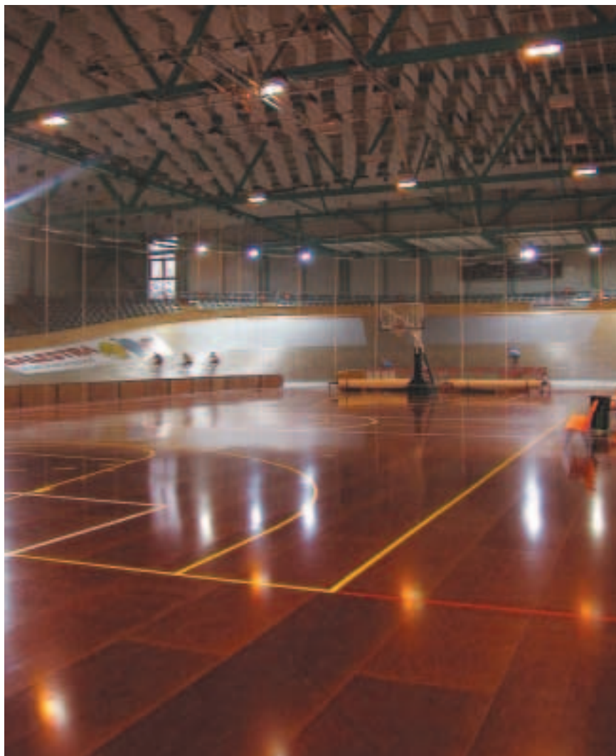
Raumakustische Massnahme: Montage von vertikalen Akustikelementen, sogenannten Baffeln, im Centre sportif de la Queue-d'Arve, Genève.
